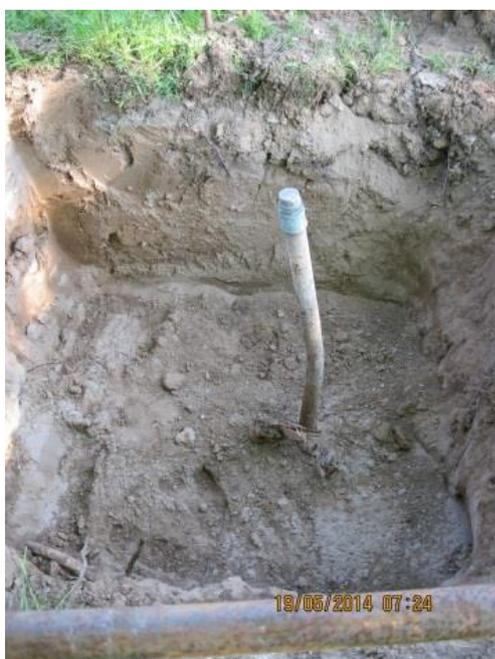
Abb. 1 - Messstelle vor Sanierung
